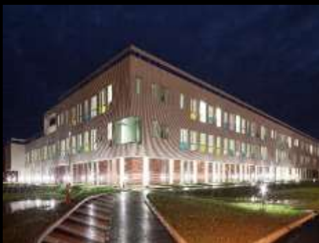
Госпитале Villeneuve-sur-Lot – Франция 35 000 кв.м. / 373 Кровать
