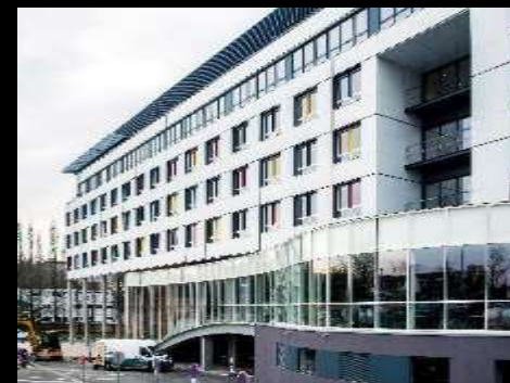
Госпиталь Лилля – Франция 80 000 кв.м. / 600 Кровать
